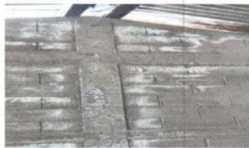
Foto 10: pintura en muros exteriores e interiores
