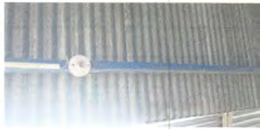
Foto 14: Reparación de lamparas
