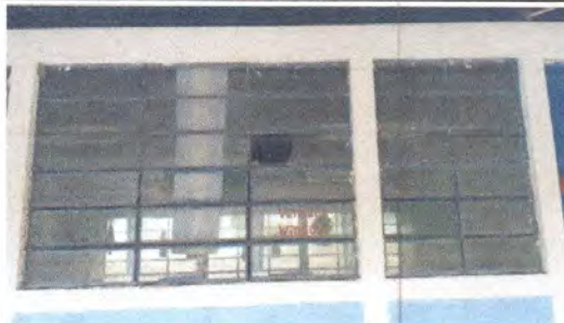
Foto 8: Sustitución de vidrios
