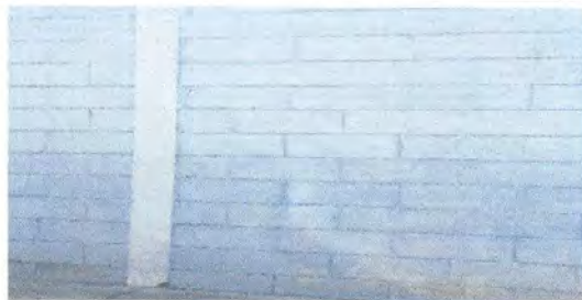
Foto 9: Pintura en muros exteriores e interiores
