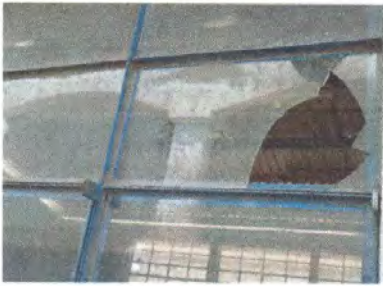
Foto 7: Sustitución de vidrios
