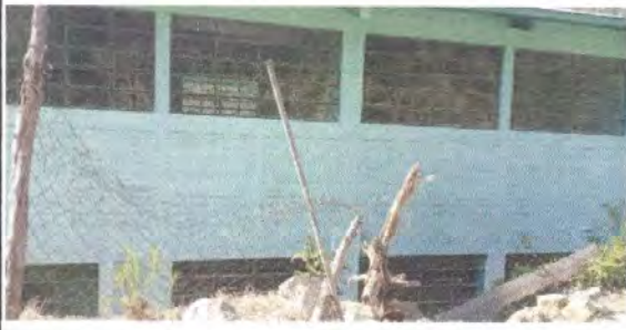
Foto 13: Reparación de tubo HG y malla galvanizada
