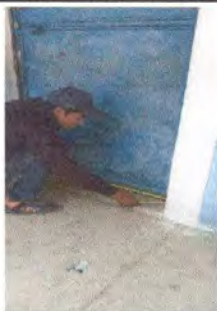
Foto 5: Sustitución de puerta de módulos
