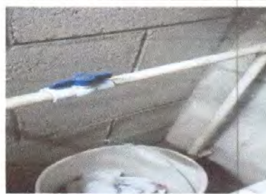
Foto 12: Sustitución de llave de paso
