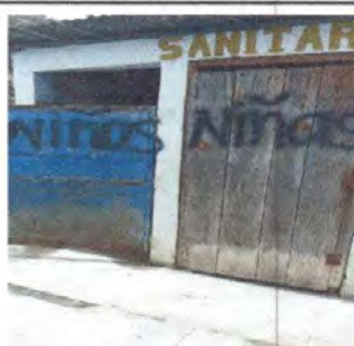
Foto 6: Sustitución de puerta en servicios sanitarios
