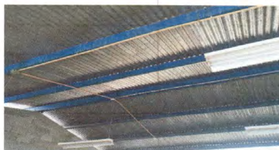
Foto 2: Mantenimiento a estructura de soporte de metal
